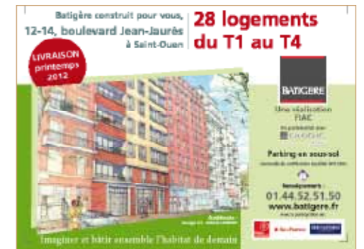
Saint-Ouen - Panneau de chantier
